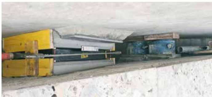
Neues Brückenlager und die Hydraulik zum Anheben der Brücke.
